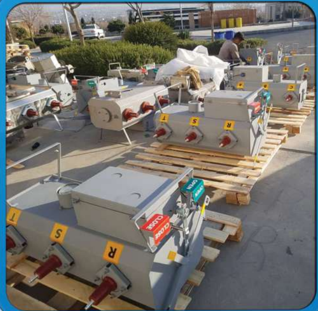
عملیات تزریق گاز SF6
