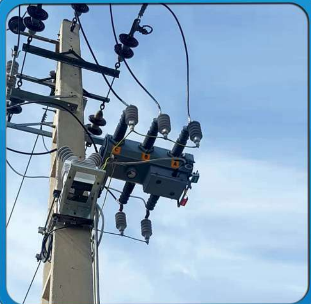
برق داری و نصب سکسیونر
