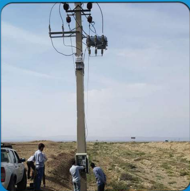
تنظیم اتوماسیون تابلو کنترل سکسیونرهای نصب شده
